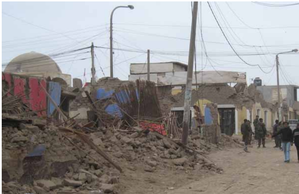
Figura 1.- Calle en Pisco tres días después del sismo. La mayoría de las casas de adobe sufrieron colapso total. La casa azul claro en el extremo derecho, sin daños, fue hecha de material noble.
